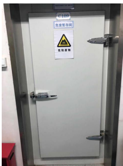
图 6 危险废物间照片
